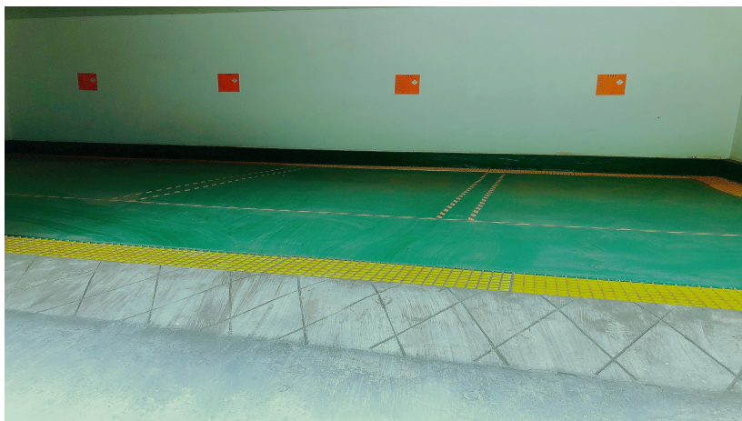
危废暂存库现场照片
