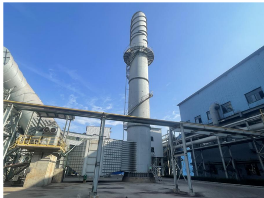
烧结机尾、环冷机、成品筛分室废气排气筒
