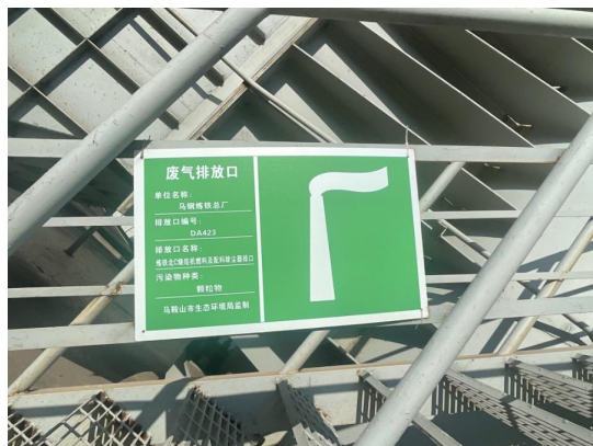
配料、燃料破碎废气排放口（DA423）标牌
