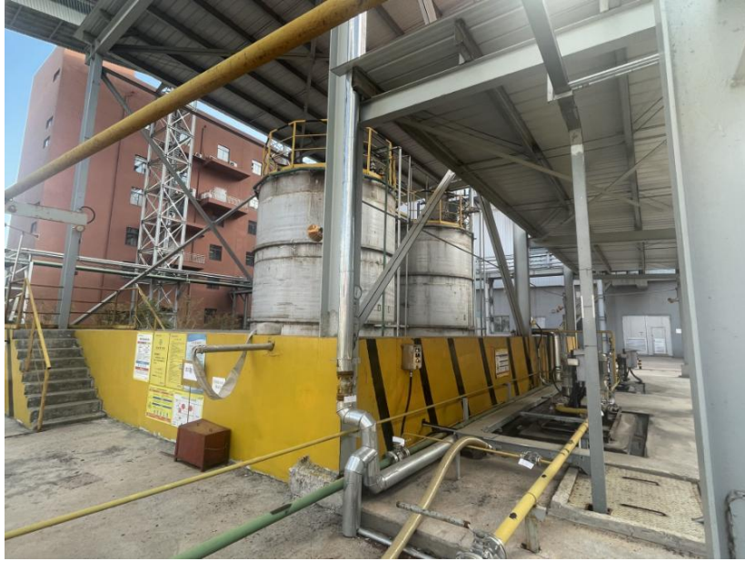
氨水储罐区现状
