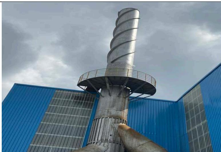
图 2 加热炉排气筒
