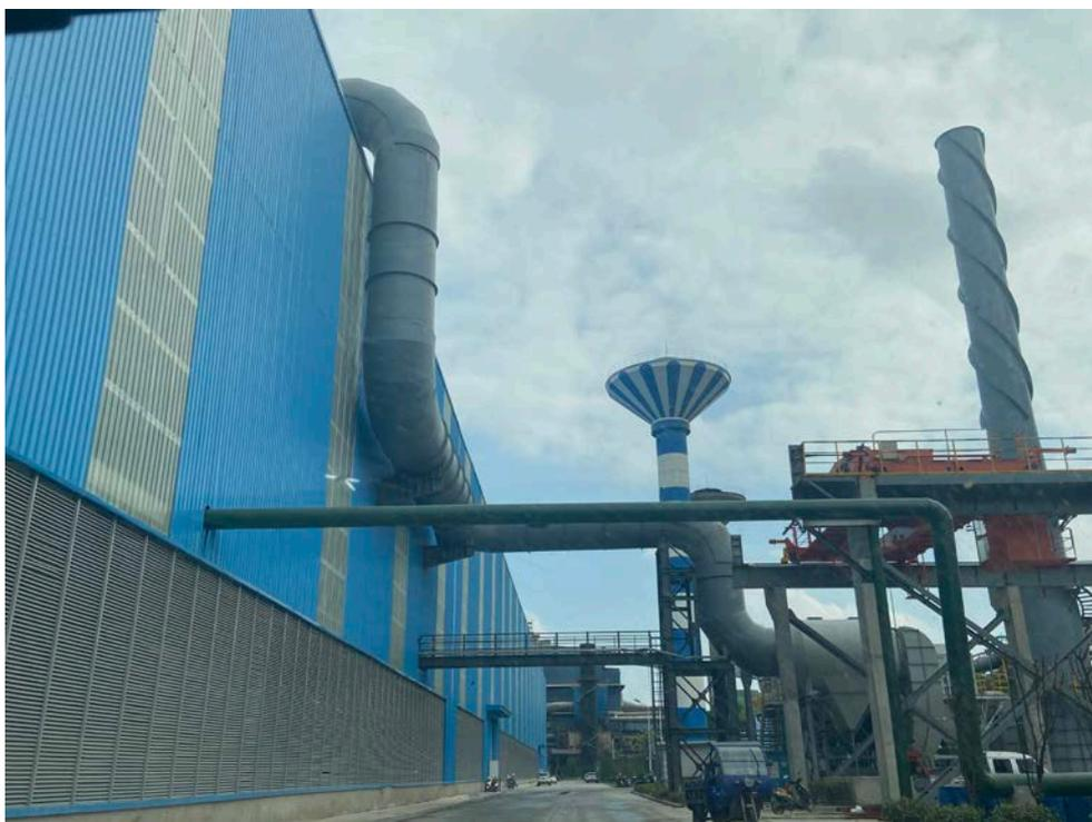
图 16 项目精轧机配套除尘
